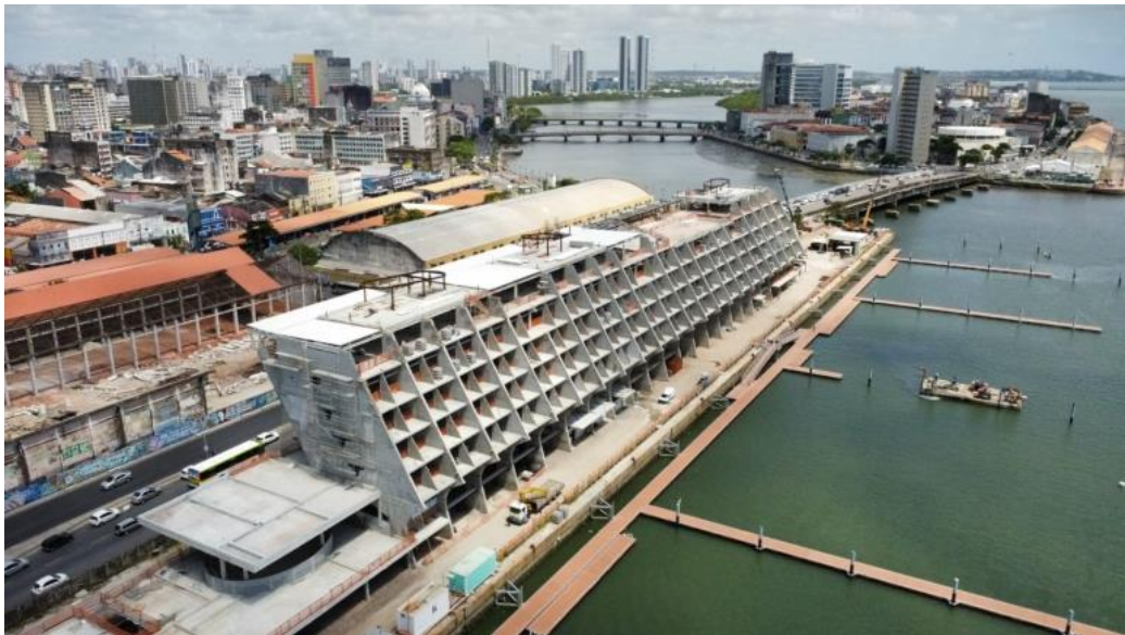
Fig.3 – Imagem aérea do hotel-marina que está em construção no Centro do Recife
