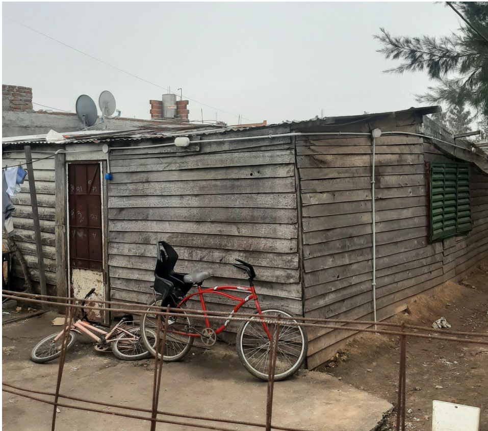
Figura 2 – Nueva instalación eléctrica exterior de una vivienda de la comunidad. Registro LIAS, 2024.
