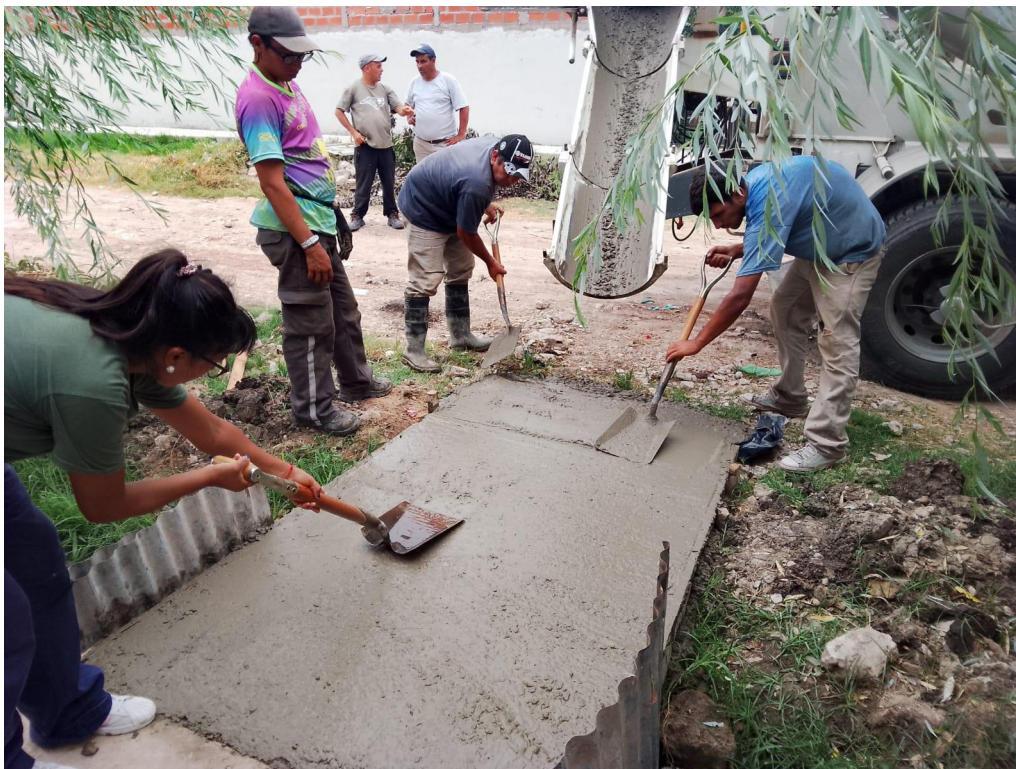
Figura 3 – Cuadrilla de trabajo realizando una vereda. Fotografía brindada por la comunidad (2023).
