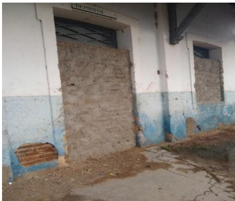
Figura 2: vista da lateral da Estação Ferroviária de Reriutaba, Ceará.
