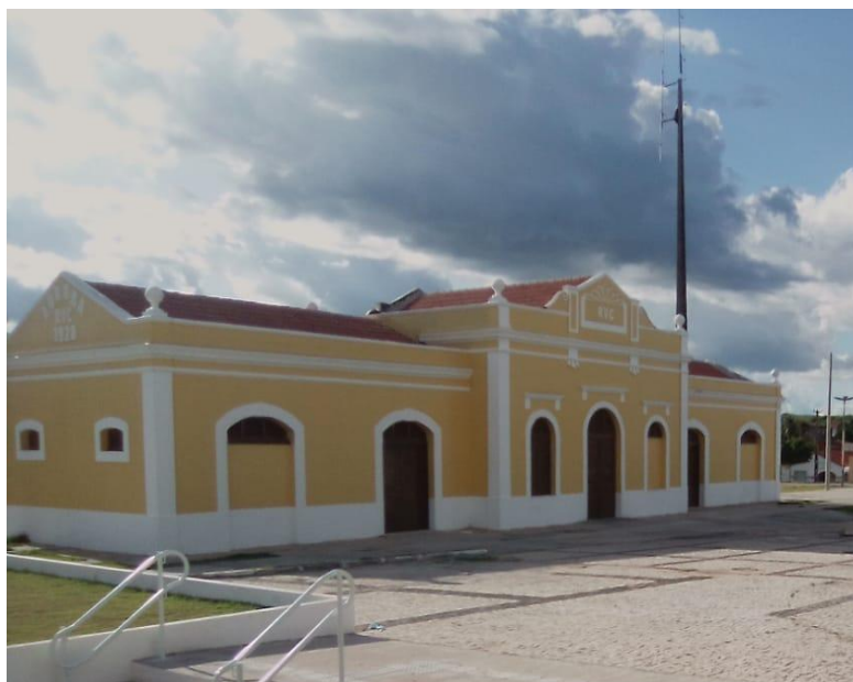
Figura 3: atual fachada da Estação Ferroviária de Aurora, Ceará.
