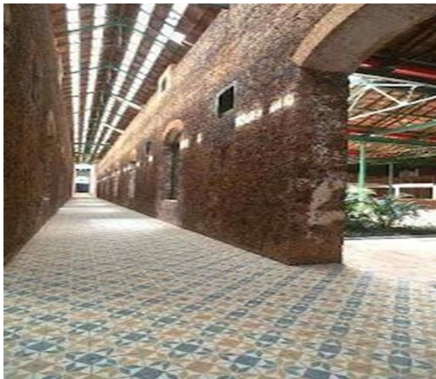
Figura 4 - Corredor com paredes histórias mantidas
