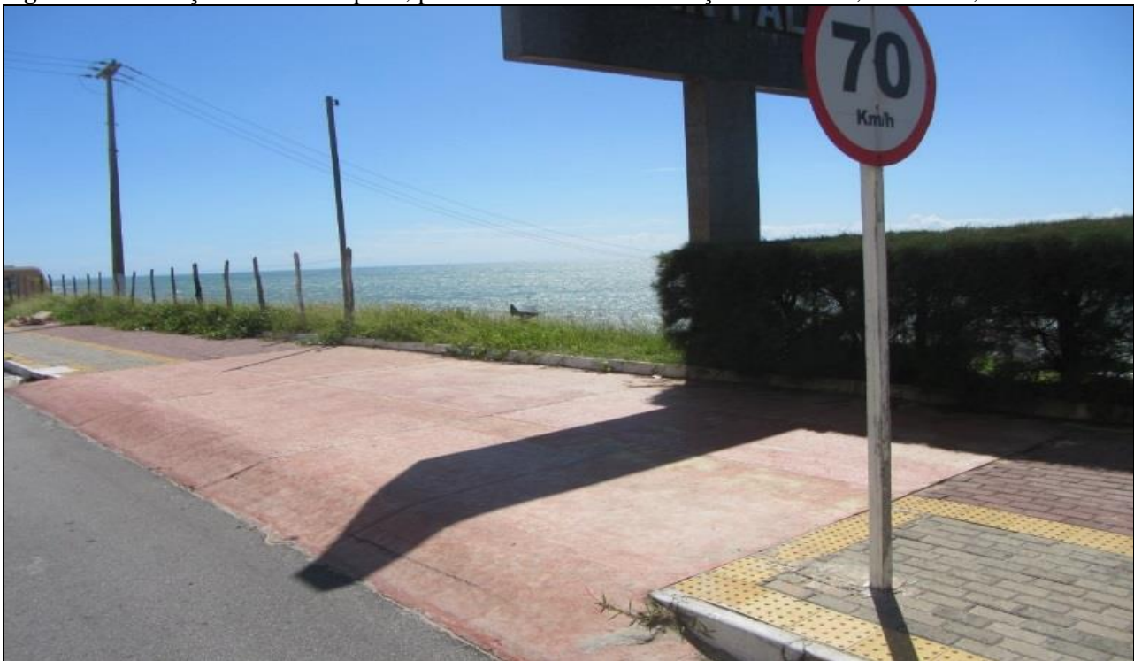
Figura 08: Indicação de acesso à praia, pintura em vermelho na calçada. O acesso, entretanto, não existe
