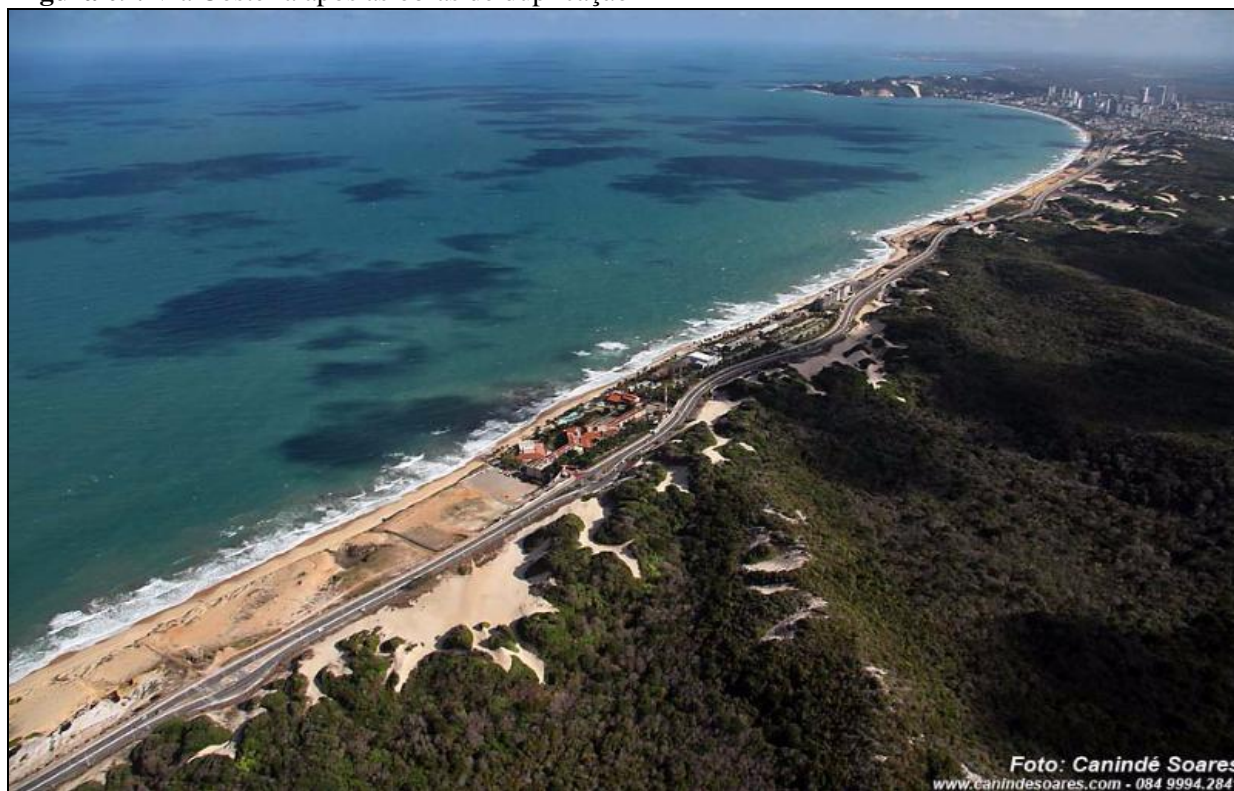
Figura 09: Via Costeira após as obras de duplicação
