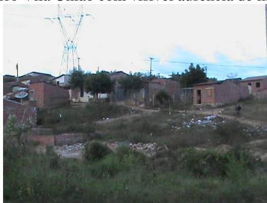
Fig. 5: Bairro Vila União com visível ausência de infraestrutura
