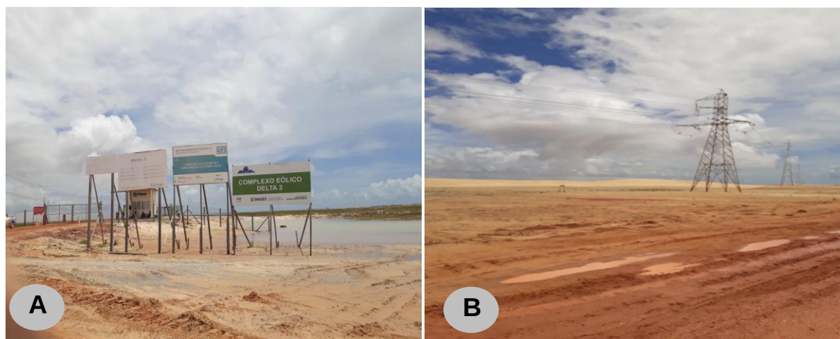
Figura 3 – Empresa Ômega Energia: A – Área de acesso e B – Instalações no Parque Eólico.
