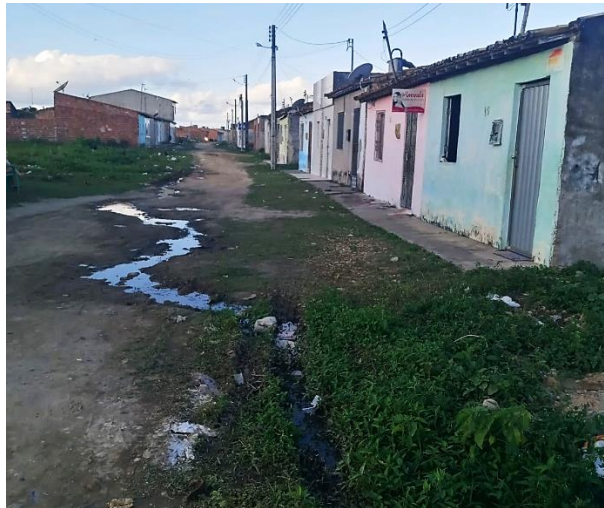
Figura 6 – Residências com infraestrutura precária, rua não pavimentada e ausência de esgotamento sanitário no bairro Pinheiro em Tobias Barreto/SE
