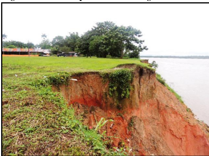
Figura 05 – Área na qual a cobertura vegetal foi retirada.
