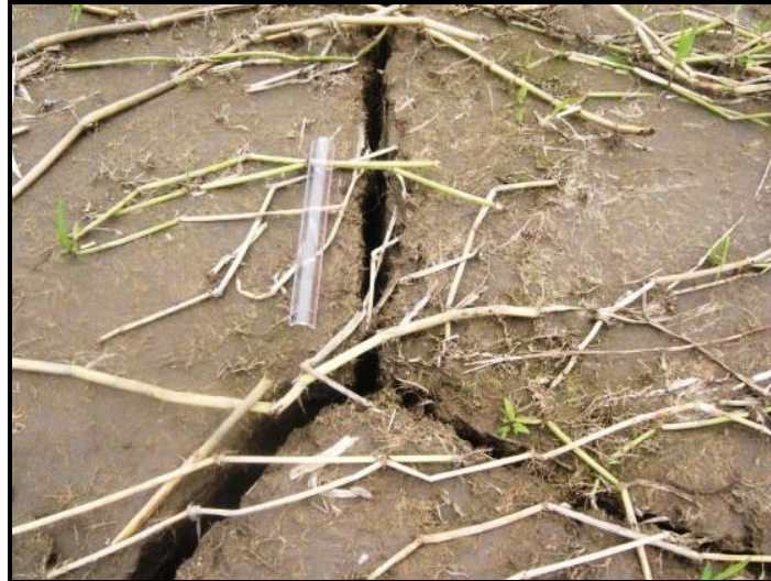
Figura 03 – Gretas de Contração em área de movimentação de massa.
