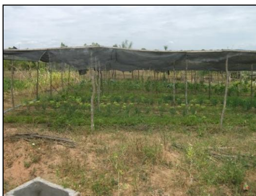
Figura 06. Construção do Sombrite
