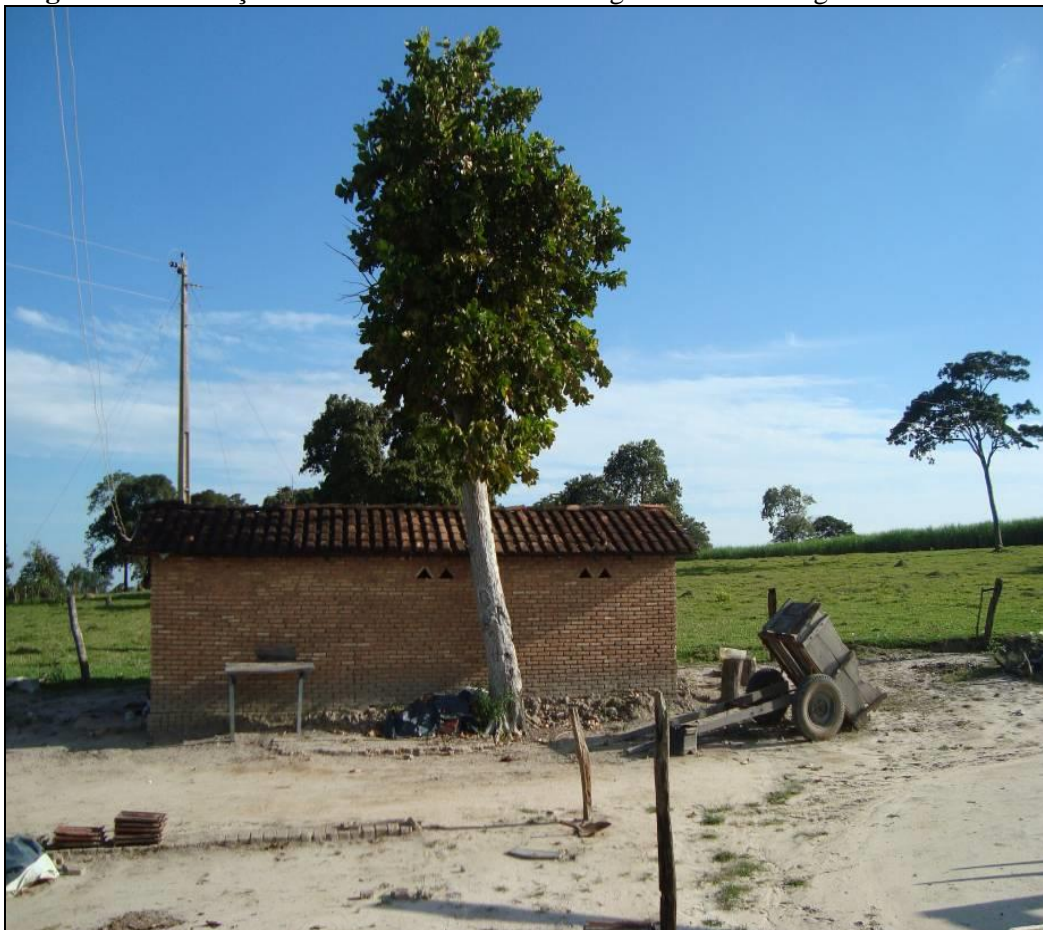
Figura 02: Habitação Tradicional localizada na região da Olaria Lagoa Bonita
