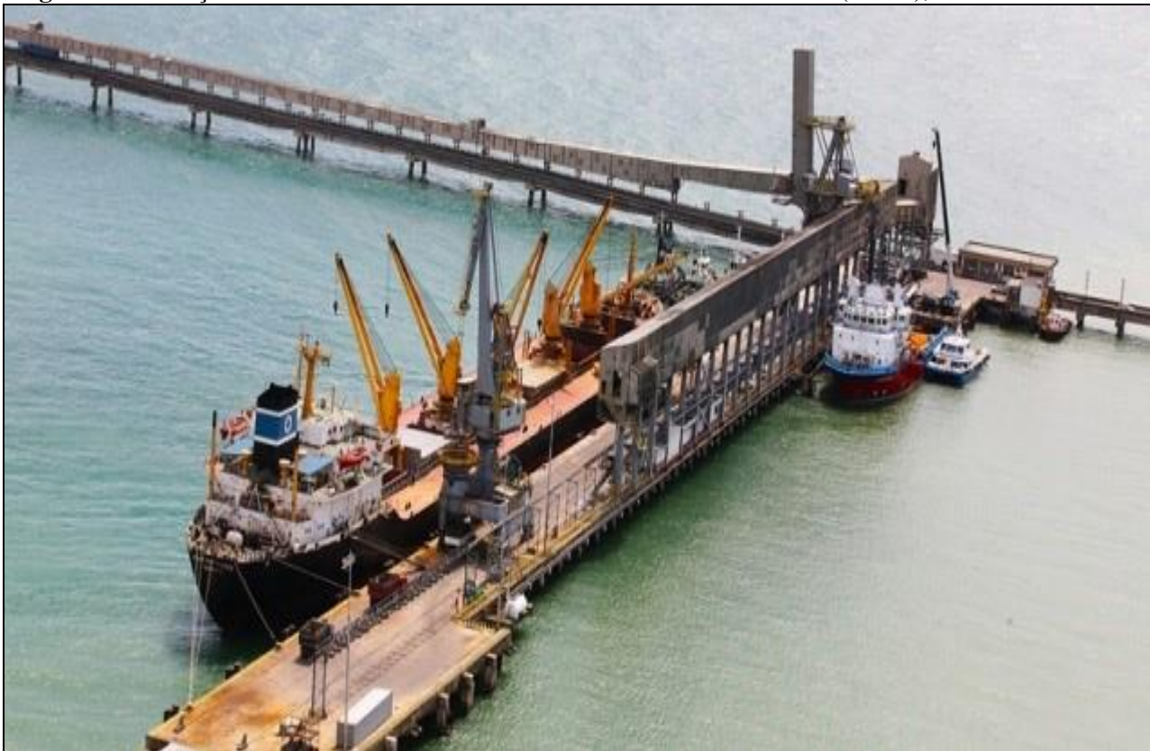
Figura 2: Instalações e navio atracado no Terminal Marítimo Inácio Barbosa (TMIB), 2017
