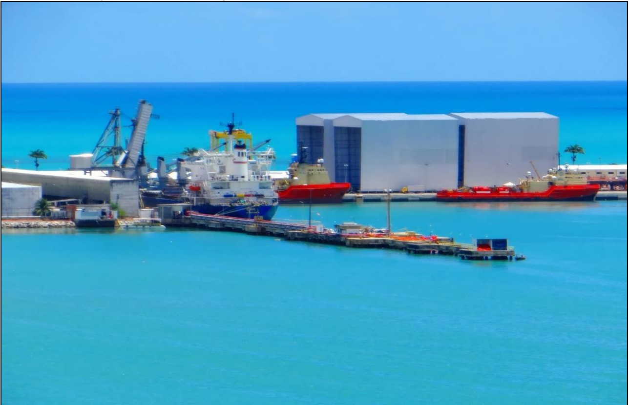
Figura 5: Instalações do Porto de Jaraguá/AL, 2017
