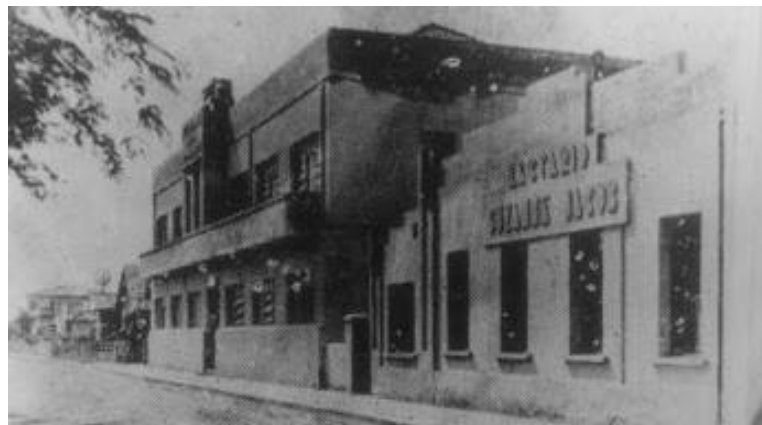
Figura 2- Maternidade Marques Basto em construção
