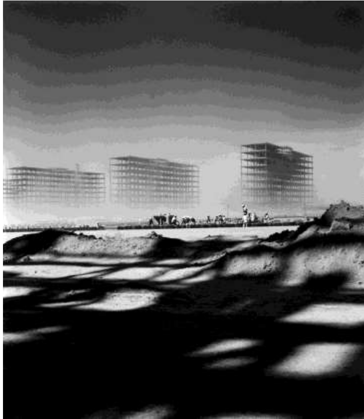
Marcel Gautherot, construção de Brasília (esplanada dos ministérios), fotografia, 1959.
