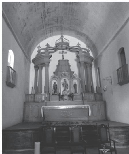
Figura 4: Interior da igreja do Amparo – altar principal
