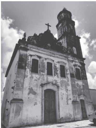
Figura 3: Fachada da Igreja do Amparo
