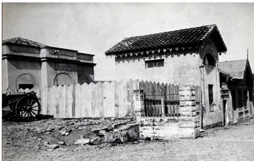
Figura 5 - Entrada do prédio do incinerador pela Av. Azenha
