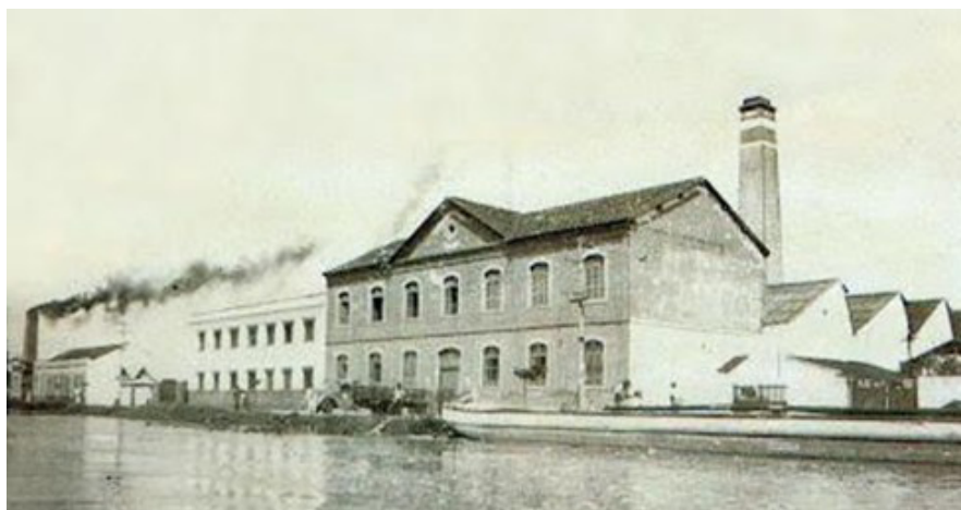
Figura 4: Fábrica de tecidos Cia. de Fiação e Tecelagem Campista.
